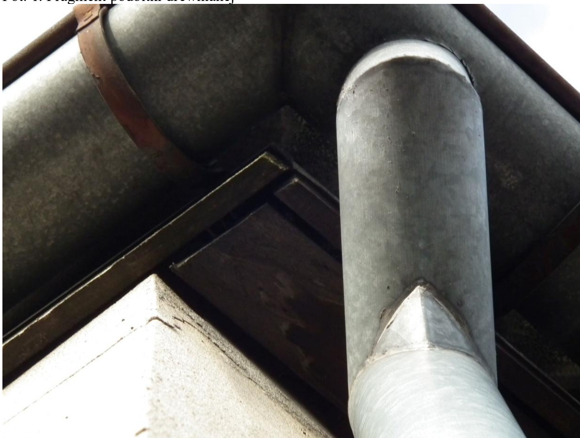
Fot. 2. Fragment podbitki drewnianej z orynnowaniem.
